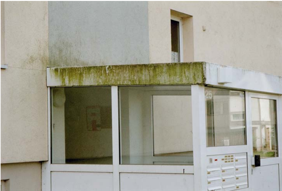
Bild 5: Unkontrollierte Wasserabläufe (1)
