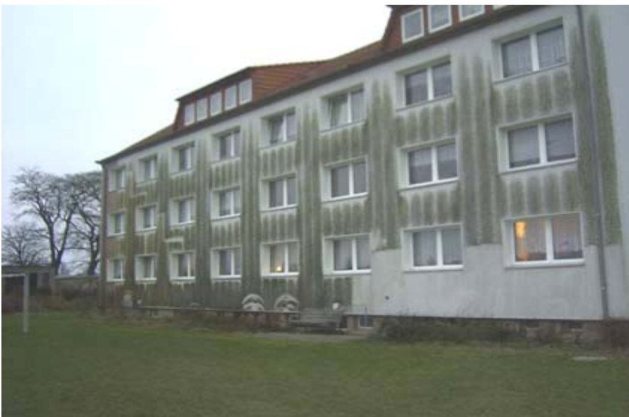
Bild 4: Vorhangsystem, partiell gereinigt (Insel Rügen)
