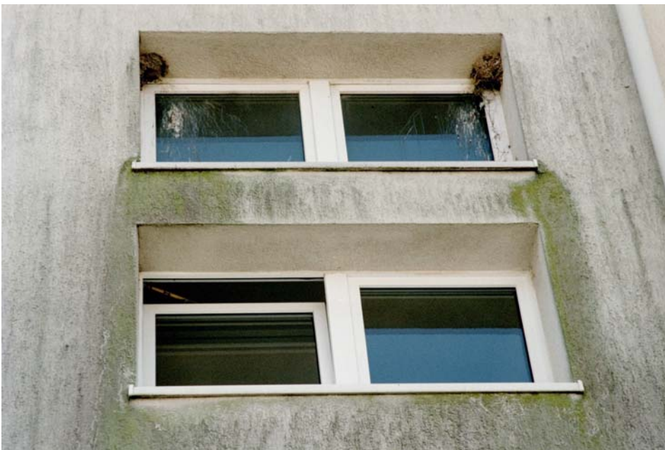
Bild 6: Unkontrollierte Wasserabläufe (2)
