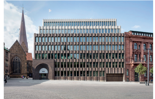
Bremer Landesbank: Die dunkle Ziegelfassade mit vielfältigen Wölbungen setzt sich aus 65 Formsteinen zusammen. Foto: Ulrich Hoppe
