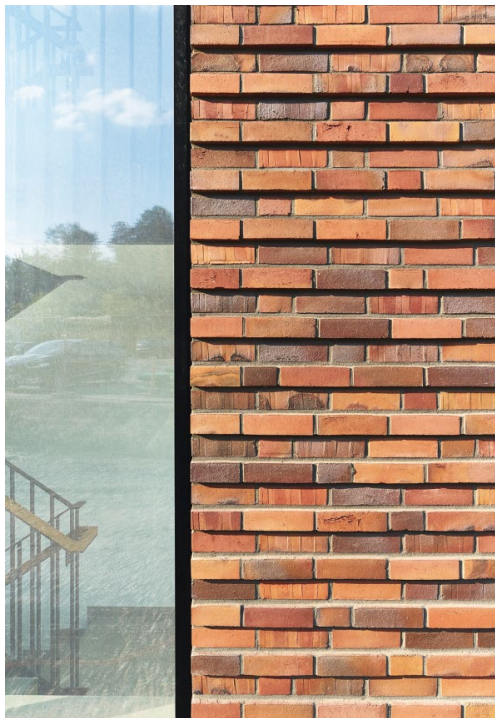
Bild 2 Reliefmauerwerk kennzeichnet den Sockel und verbindet Bauteil I und II
