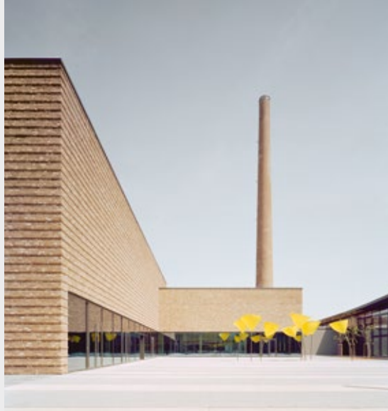
◀ Neubau Besucher- und Kundenzentrum Kärcher-Areal, DE Architektur: Reichel Schlaier Architekten mit Alfred Kärcher GmbH & Co. KG, DE
