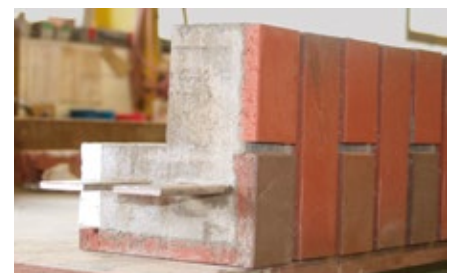
▲ Ziegelfertigteilsturz
